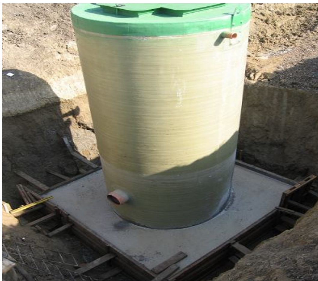
Установка вертикальной емкости, анкерение и бетонирование.
