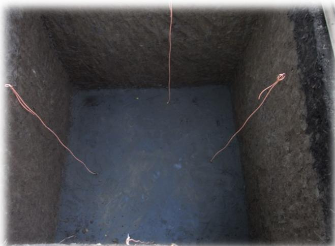
Во избежание выталкивания установки грунтовыми водами и для снижения бокового давления грунта установку необходимо заякорить. Для якорения используют дополнительное оборудование в виде синтетических тросов и железобетонных плит. Диаметр троса – 8-16мм. В обязанности монтажника входит определение толщины и прочности бетонных плит, требуемых для соответствующих условий грунта, с учетом плавучести установки при откачке осадка,
