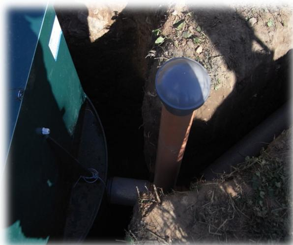
Уклон подводящей трубы должен составлять 10мм/м. Необходимо убедиться, что в подающей трубе отсутствуют «водные карманы», они могут нарушить нормальную циркуляцию воздуха в системе очистки.
